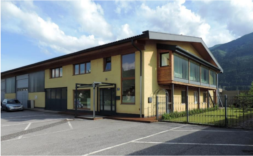
Bild: Unser Wasser-Produktions-Gebäude in A-9800 Spittal an der Drau ( in miete 2017-2020)
